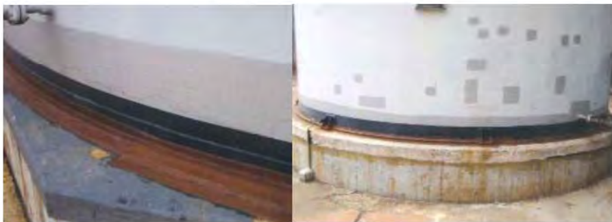
高温タンク底板防食
