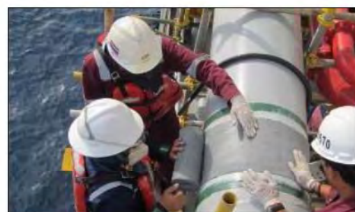
パイプライン
