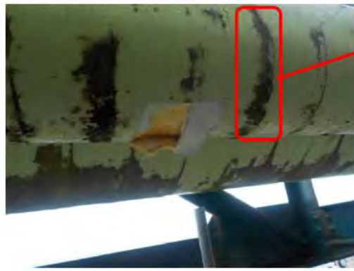
油分が表面保護材の間から染み出ている状況
