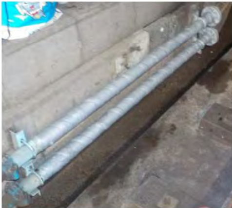
鉄道（下水配管）
