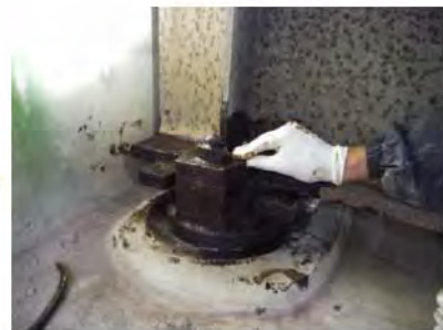
プライマー塗布
