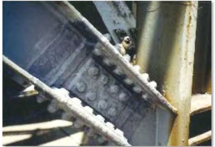
土木・建築構造物のボルト・ナット
