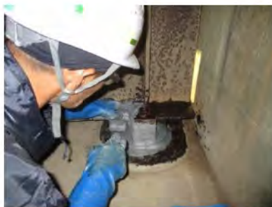
WAX-TAPE貼付状況
