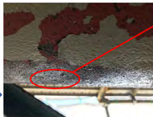
ペトロラタムテープを除去すると、水分を含んでいる錆層が確認でき腐食が進行していることがわかる。
