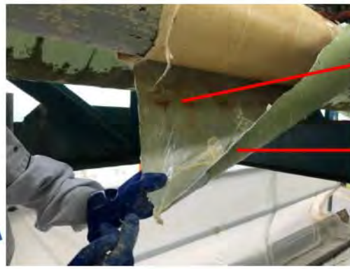
油分が表面保護材の間から染み出ている状況
