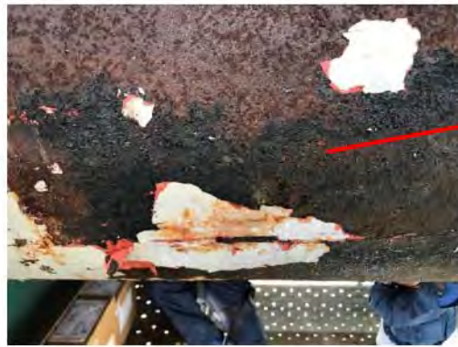
ペトロラタムテープを除去すると、水分を含んでいる錆層が確認でき腐食が進行していることがわかる。
