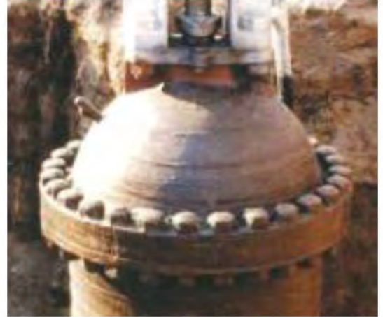
大口径バルブの防食
