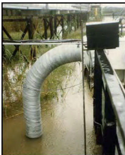
1984年に施工 2019年現在（35年経過） においても腐食確認されず
