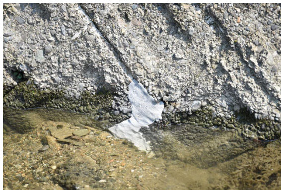
施工後の様子
