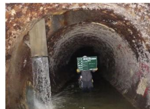
化学的弱部(腐食のおそれが大きい箇所)における事例
