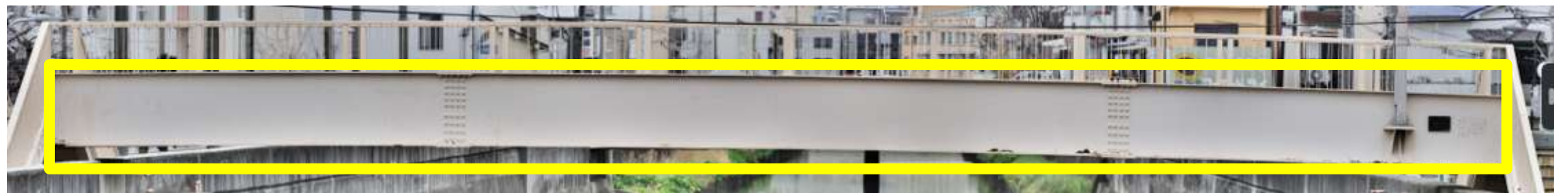
橋梁側面(北側)
