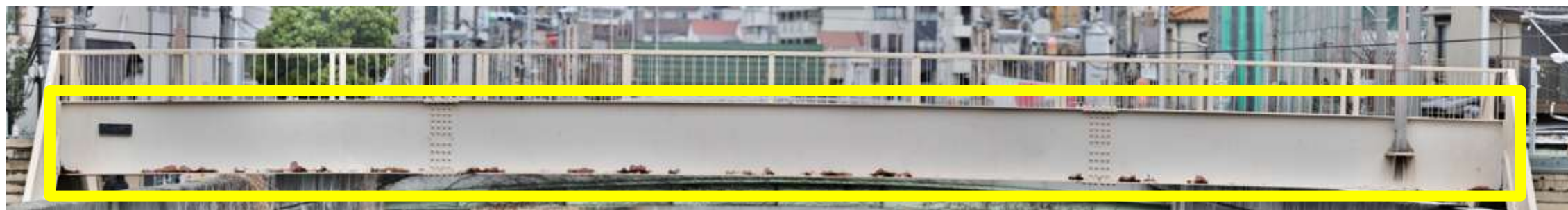
橋梁側面(南側)
