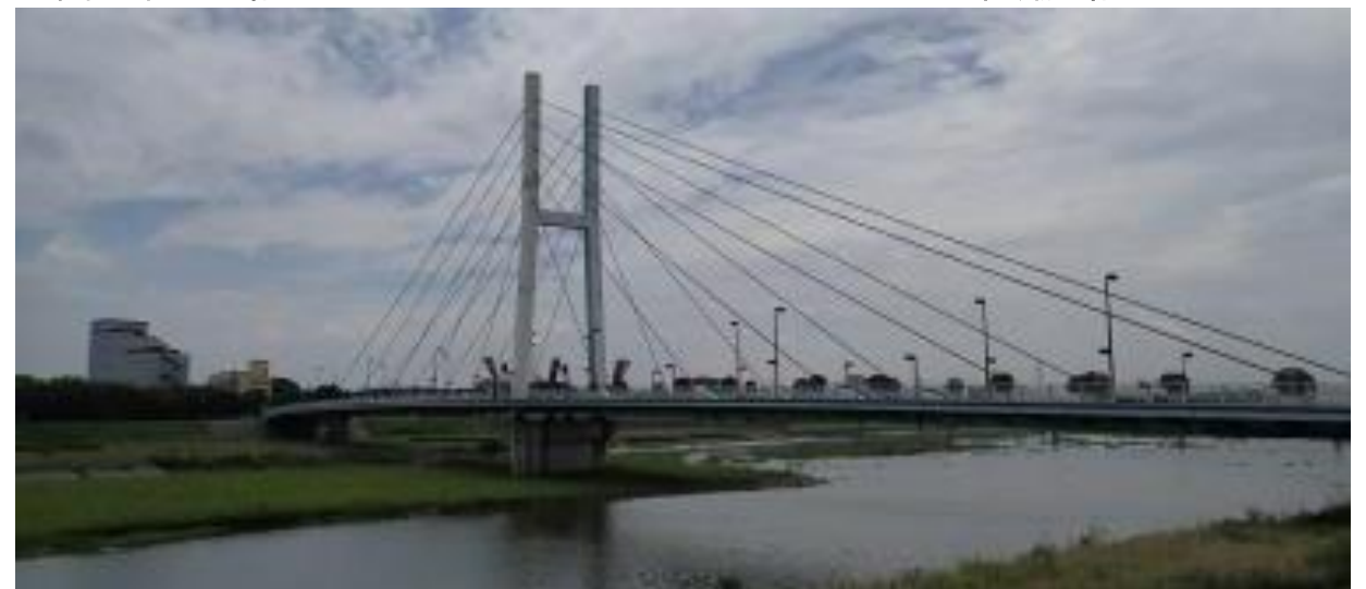
神津大橋 L=m PCプレテン床版橋
