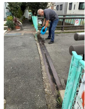
漏水確認試験
