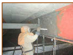
送気マスク着用によるブラスト施工状況
