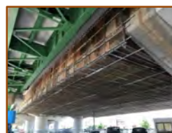
研削材・粉じんの飛散防止設備が必須
