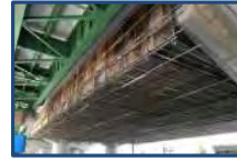
塗替え塗装工事と同時施工することで、 プラストと用の防護工を併用でき ショットの飛散防止が可能
