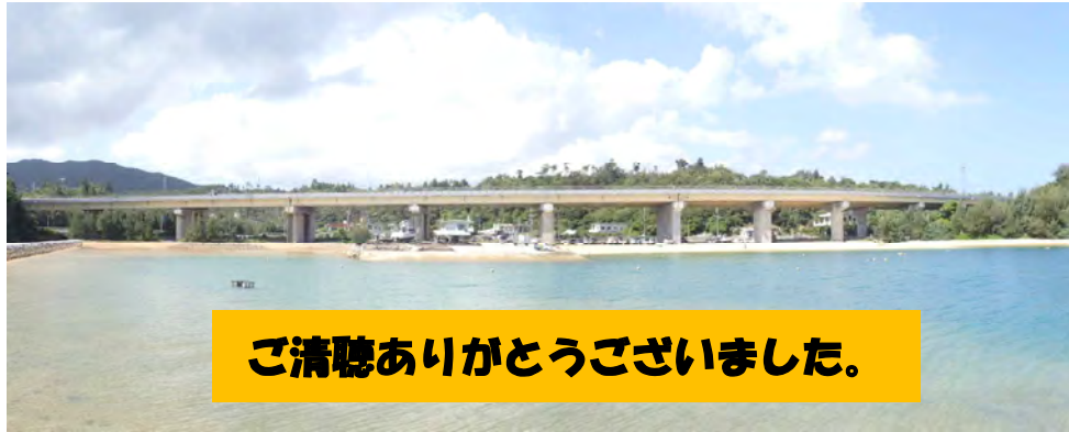
写真：沖縄自動車道許田高架橋 IH施工約50,000㎡
