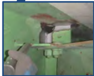
圧縮空気による噴射のため熱線度も不要 作業効率も良く、狭路部への施工も可能
