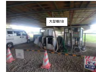
ヤード設置写真②
