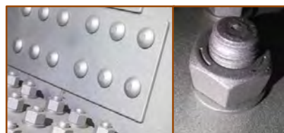
添接部でもきれいに除錆・塗膜除去が可能
