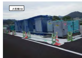
橋面上設置写真
