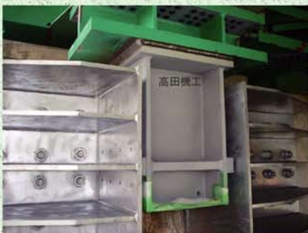
図13 鋼箱桁の適用例 (下フランジに取付け)
