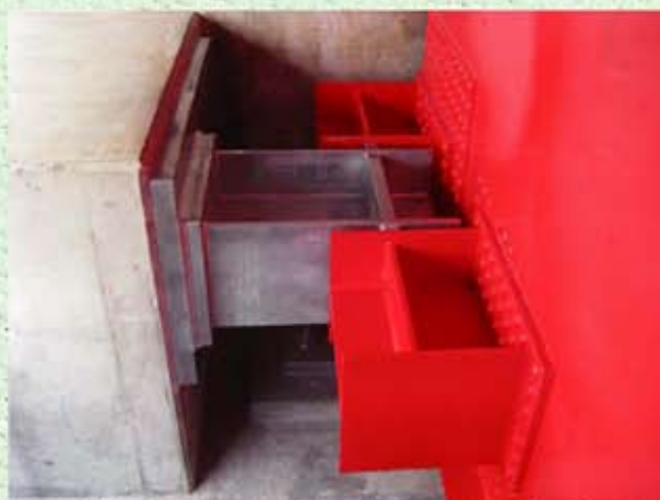
図12 鋼箱桁の設置例 (腹板に水平取付け)
