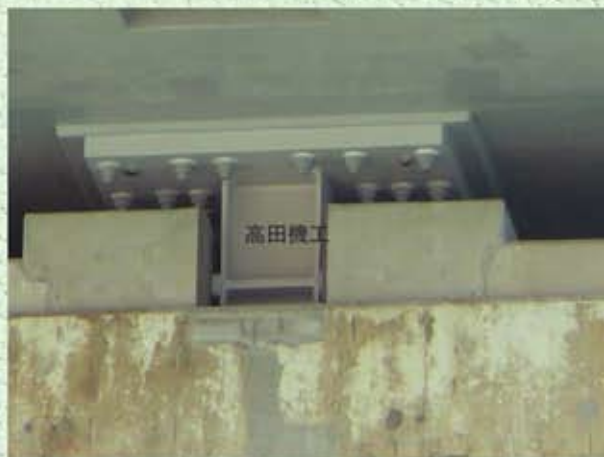
図10 PC箱桁の設置例 (下フランジに取付け)
