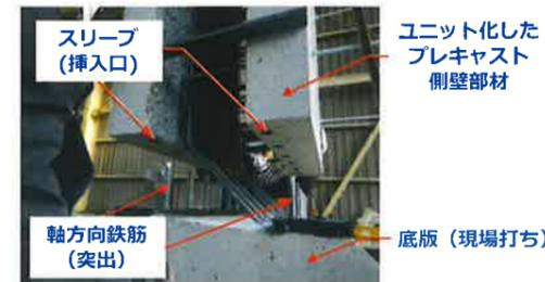
写真-3 プレキャスト部材の接合状況
