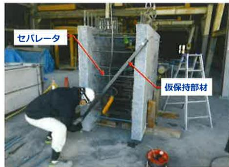
写真-2 ユニット化したプレキャスト側壁部材
