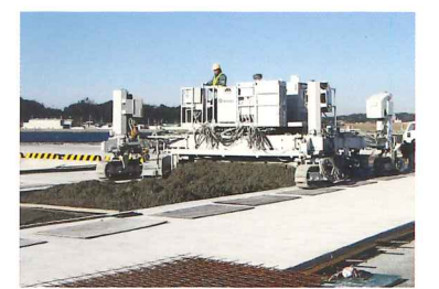
護岸コンクリート工事 (スリップフォーム工法)
