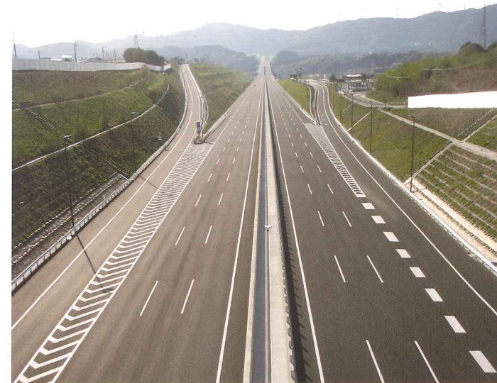
第二東名高速道路 浜松舗装工事 (静岡)
