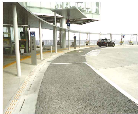
日立駅前広場〈茨城〉…高強度パーミアコン
