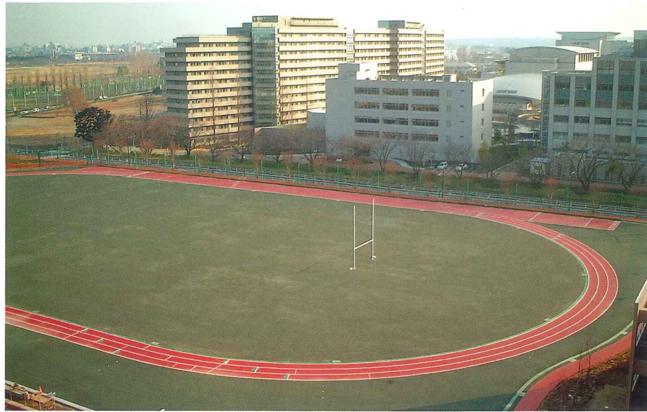
東京外国語大学基幹・環境整備（屋外運動場等）工事〈東京〉
