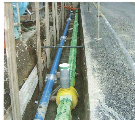
ガス内管（LPPE150mm）埋設
