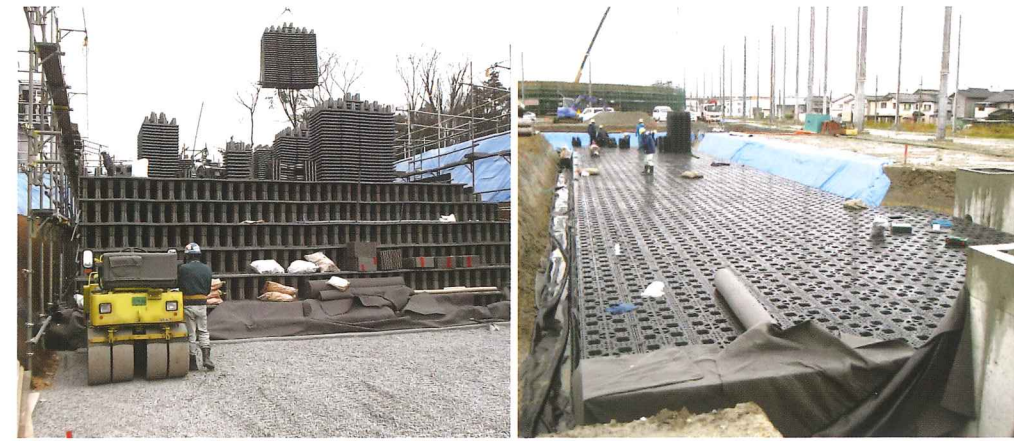
藤沢物流センター〈神奈川〉…リ・タンスイシステム 高岡西部総合公園〈富山〉…リ・タンスイシステム
