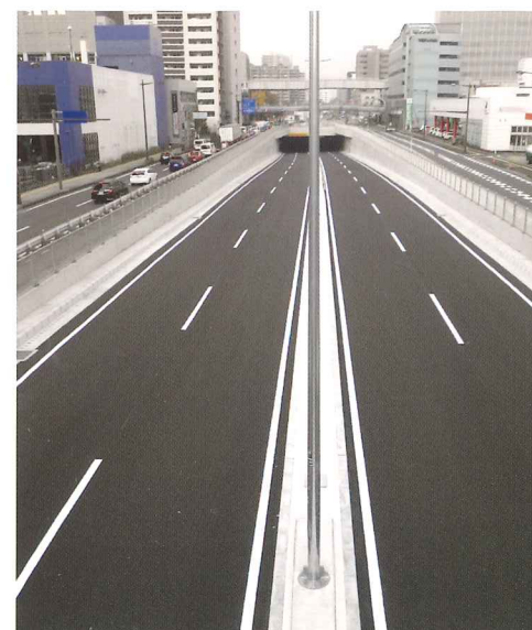
国道 357 号湾岸千葉地区舗装工事 (千葉)
