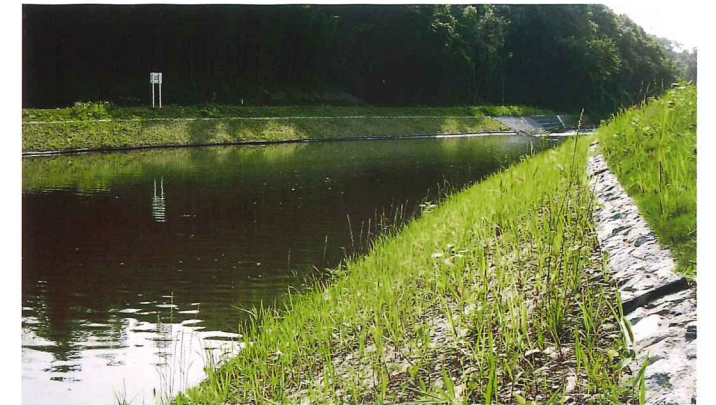
桜川〈茨城〉…植生護岸用パーミアコン工法
