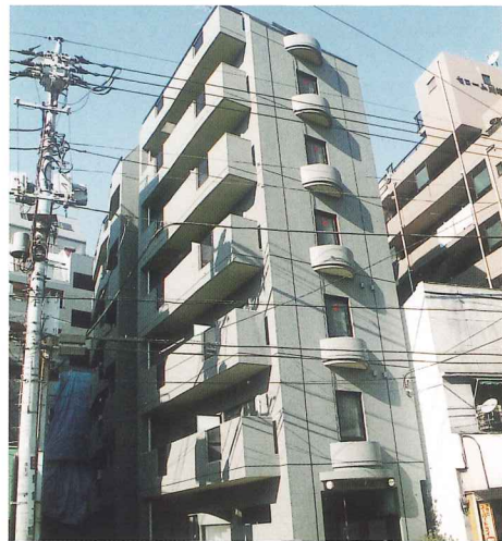
タイホープラザ川崎新築工事〈神奈川〉
