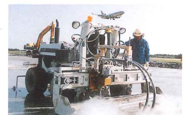
空港誘導路コンクリート版ハツリ工事 (ハイドロミリング工法)
