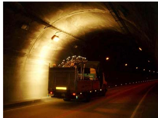
トンネル覆工での撮影状況
