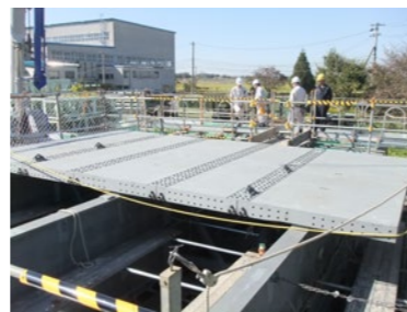
施工性確認試験状況
