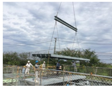
実大架設ブロック吊上状況
