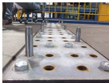
デッキプレート接合部
