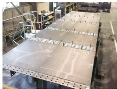
架設ブロック地組立状況
