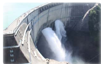
CASE4. ダム施設
