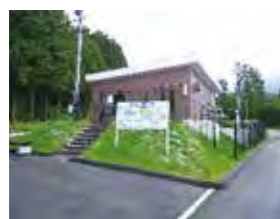
開発事例1 落合平石小水力発電所
