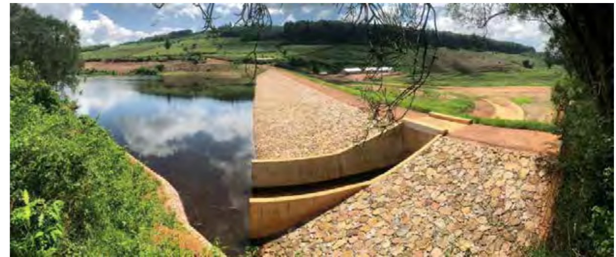
盛立が完了し、農業用水を溜めるチミマ堤体
