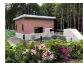
開発事例2 神坂霧ヶ原小水力発電所
