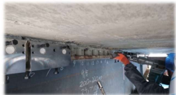
モルタル撤去状況
