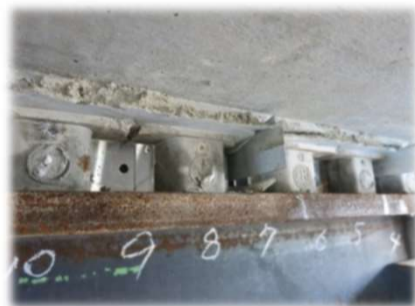
鋼製補強材撤去後
