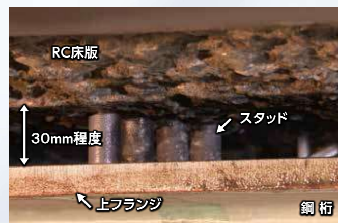
床版と鋼桁の分離状況
