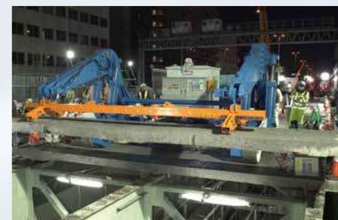
上下線各々一体で撤去
