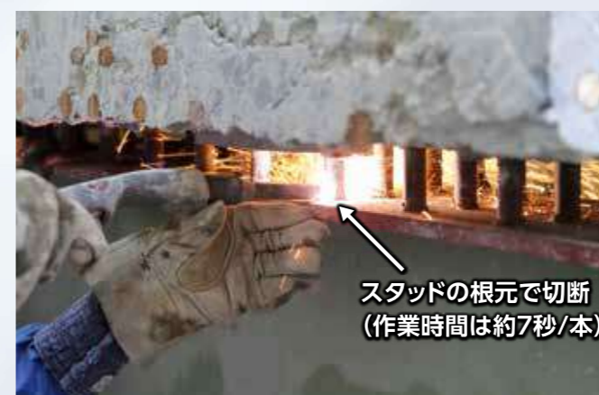
プラズマ切断機によるスタッドの切断
