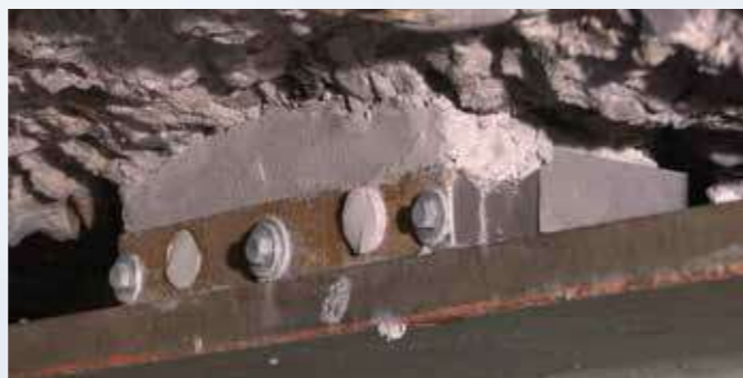
仮補強材により合成桁橋の機能低下を抑制
