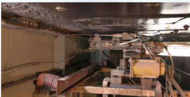
ウォータージェットによる接合部の除去
