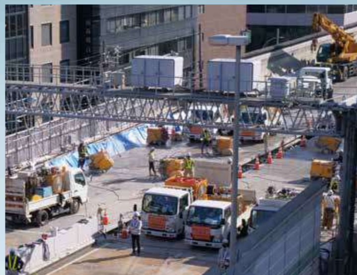
床版と鋼桁の分離状況
