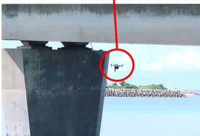
市販のUAVを使用した離島海上橋橋脚部の撮影状況
