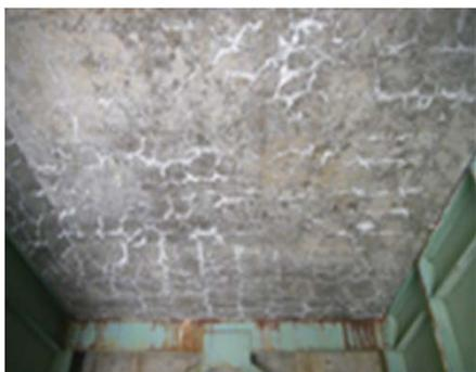
ひび割れが進展した橋梁の多くは、耐荷力不足が原因です。床版厚を増すことで耐荷力・せん断力が向上し、ひび割れに強い躯体となります。
