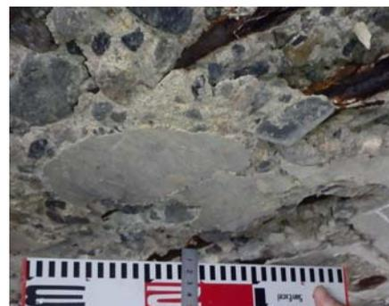
かぶり厚が不足する橋梁は中性化が進行すると鉄筋の腐食が始まります。本工法は増厚することで床版下面全体のかぶり厚を確保します。
