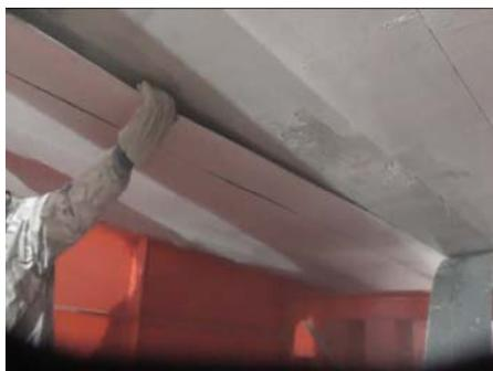
透水性能のないシート内部は滞水しやすく、特に寒冷地ではシートの浮きが早期に拡大します。積層貼りの効果が限定的な場合など、再補強工法として本工法が活用されます。
