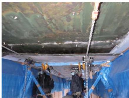
床版下面に接着された鋼板の内部ははがしとるまで点検ができません。接着の切れた鋼板内部に滞水した場合床版の土砂化が進んで重大な損傷となる可能性があります。
