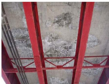
遊離石灰のある躯体に樹脂は注入できません。樹脂導入路と増厚したモルタル自体がシール材となる本工法では樹脂注入が可能で既設部と増厚部を確実に一体化させます。
