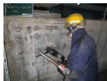
写真-2 抜き取り状況
