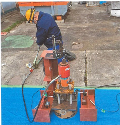
引抜き試験状況
