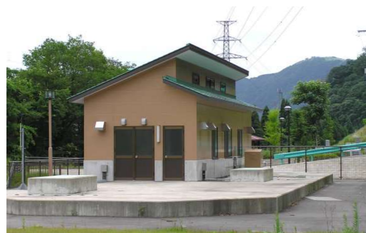
特定環境保全公共下水道 終末処理場
