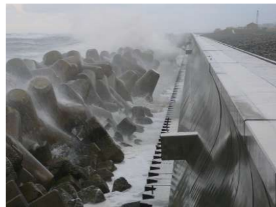
石川海岸直立堤復旧工事 (地盤工学会 北陸支部 表彰)
