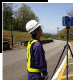
3次元レーザによる調査
