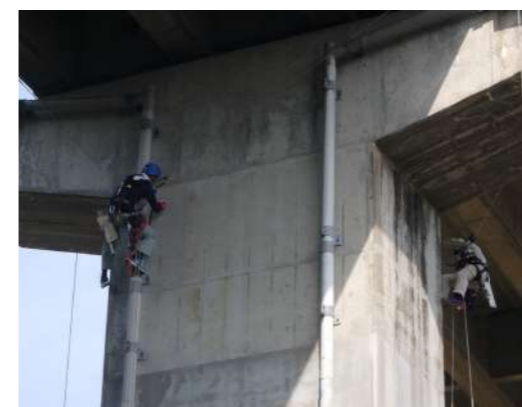
南砺市橋梁点検
