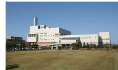
松任石川環境クリーンセンター 基幹改良工事
