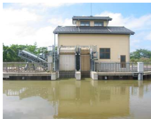
湛水防除事業 梯川左岸地区 浮柳排水機場
