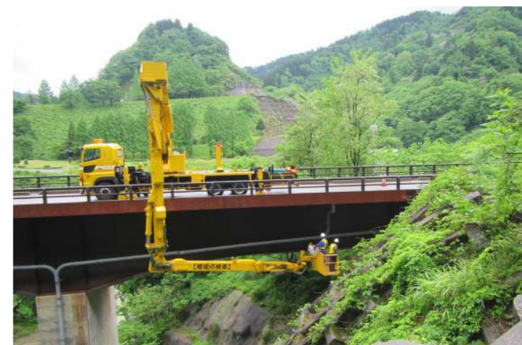
石川土木橋梁点検
