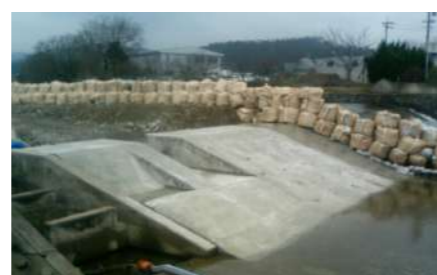
鹿ヶ鼻固定堰 (既設固定堰のリニューアル)
