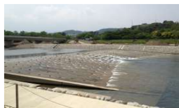
犀川上流工区緩傾斜落差工
