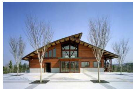
富山地区地球温暖化対策施設 (北代緑地パークセンター管理棟)
