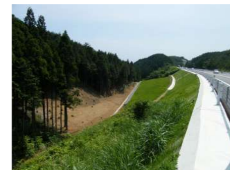
能登半島地震 能登有料道路 (現のと里山海道) 復旧 [復旧後]
