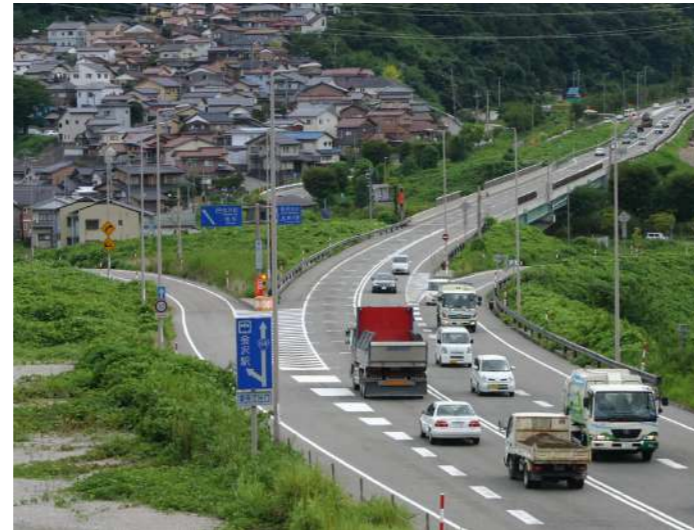
金沢東部環状道路（山側幹線）
