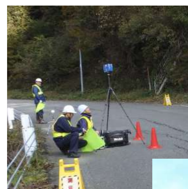
地上レーザスキャナ による計測
