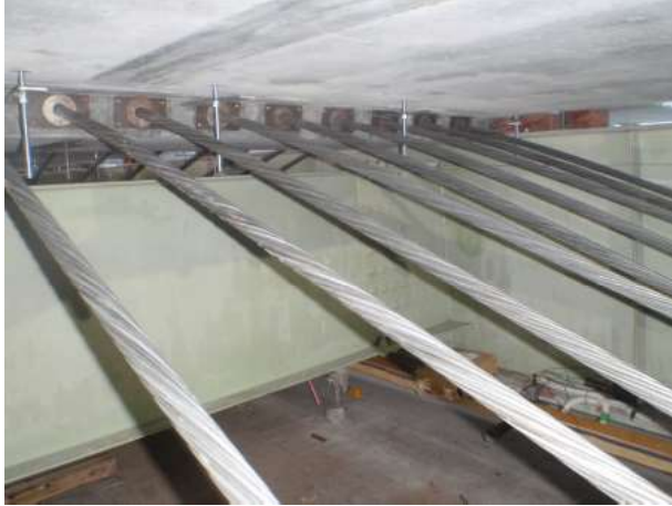
スパン中央部での PC 鋼材挿入および緊張状況
