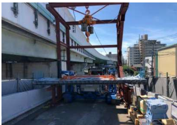
床版の荷取り
