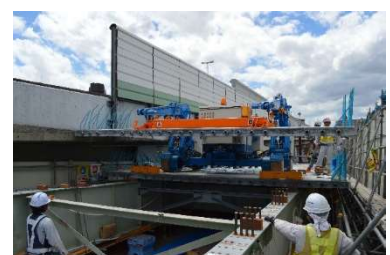
床版の据付け
