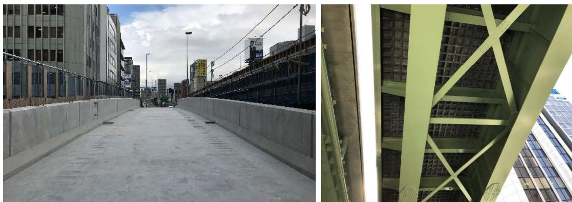
ワッフル型 UFC 床版を使用した阪神高速道路 1 号環状線 信濃橋入口
