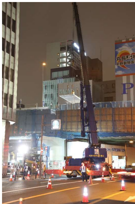
60t クレーンによるワッフル型 UFC 床版の架設
