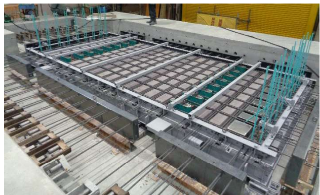
ワッフル型 UFC 床版用の型枠
