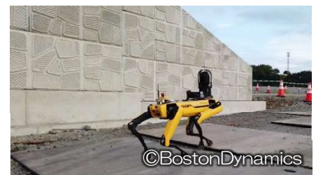
屋外、造成現場での路面走行 (竹中土木)
