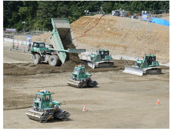
管制室からの指示で複数の重機が連携して作業を行う
