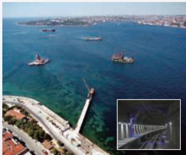
④ ポスボラス海峡横断鉄道トンネル(トルコ共和国)
