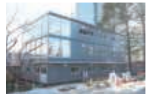
赤坂中学校等整備工事作業所事務所 *技術センターZEB実証棟「人と空間ラボ」でもBELS認証・WELL認証を取得しています。P.21参照
