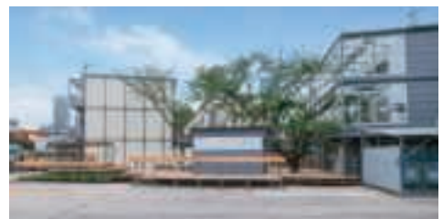
事例2 仮設型ワークスペース： 「ウエルネス作業所」(赤坂中学校等整備工事作業所事務所)
