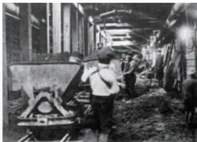
② 東京地下鉄道(上野～浅草間)
