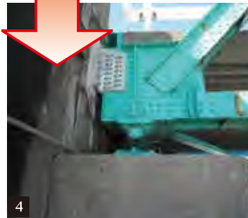
支承アンカーボルト補修（据え直し）
