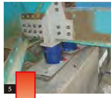
支承アンカーボルト補修（据え直し）
