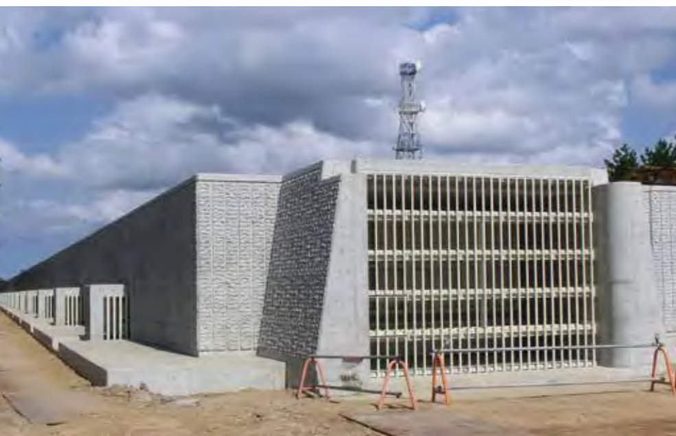
志賀原子力発電所 防潮堤排水ゲート
