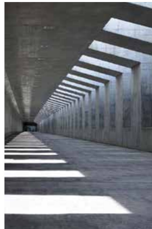
東京外環自動車道 国分工事 | 千葉県 | 2019 |
