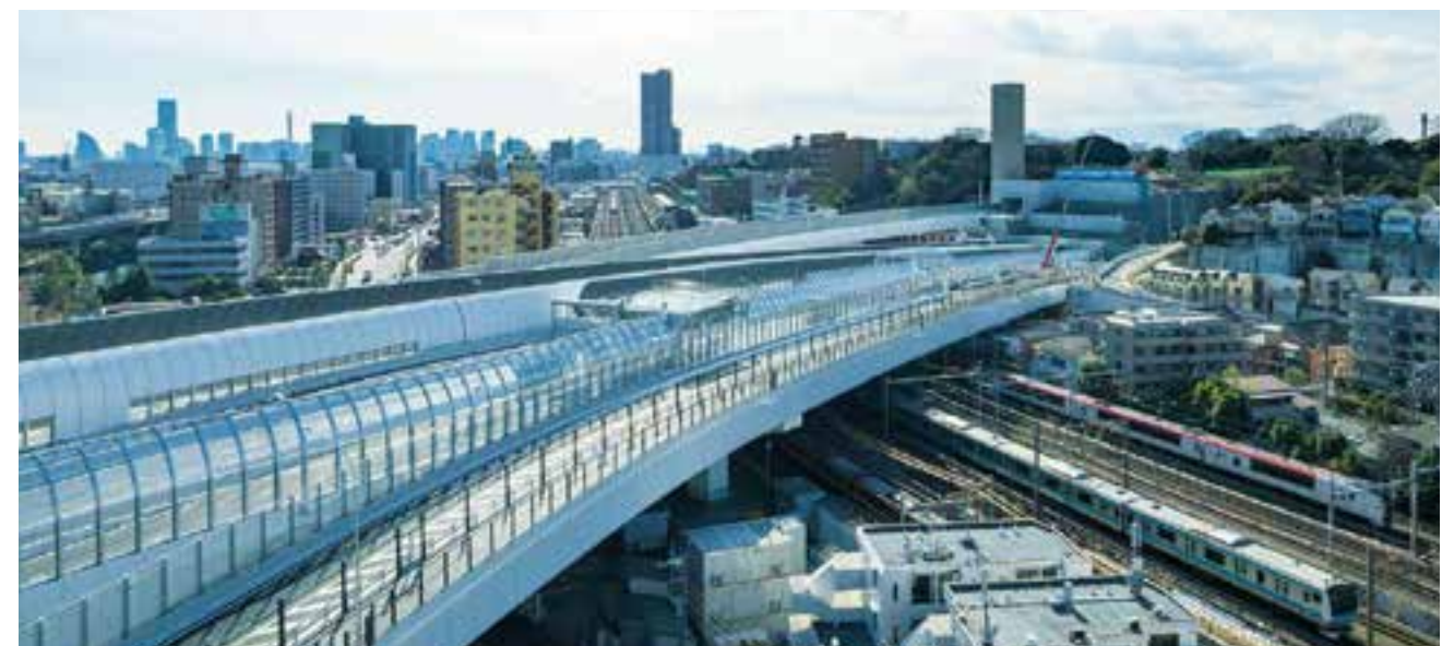
首都高速道路 横浜環状北線 鉄道交差部 |神奈川県|2017|
