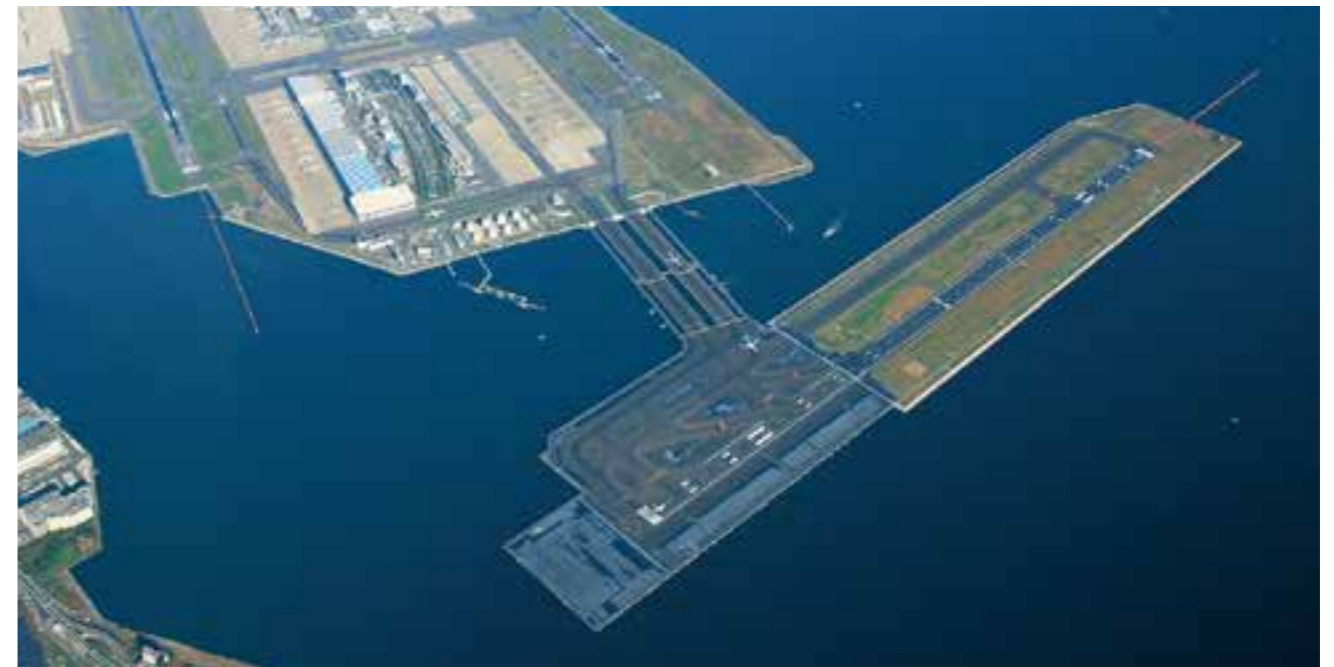
東京国際空港 (羽田空港) D滑走路 | 東京都 | 2010 |
