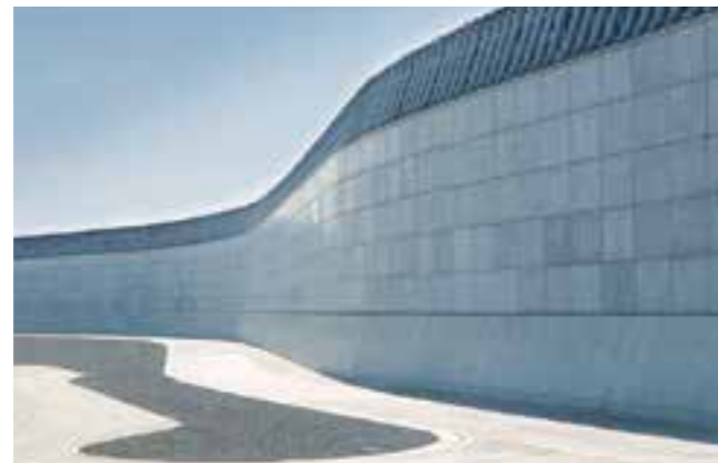
浜岡原子力発電所 防波壁 (西工区) | 静岡県 | 2016 |
