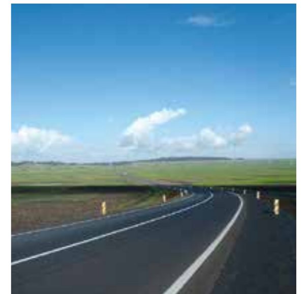
エチオピア幹線道路改修工事 | エチオピア | 2016 |
