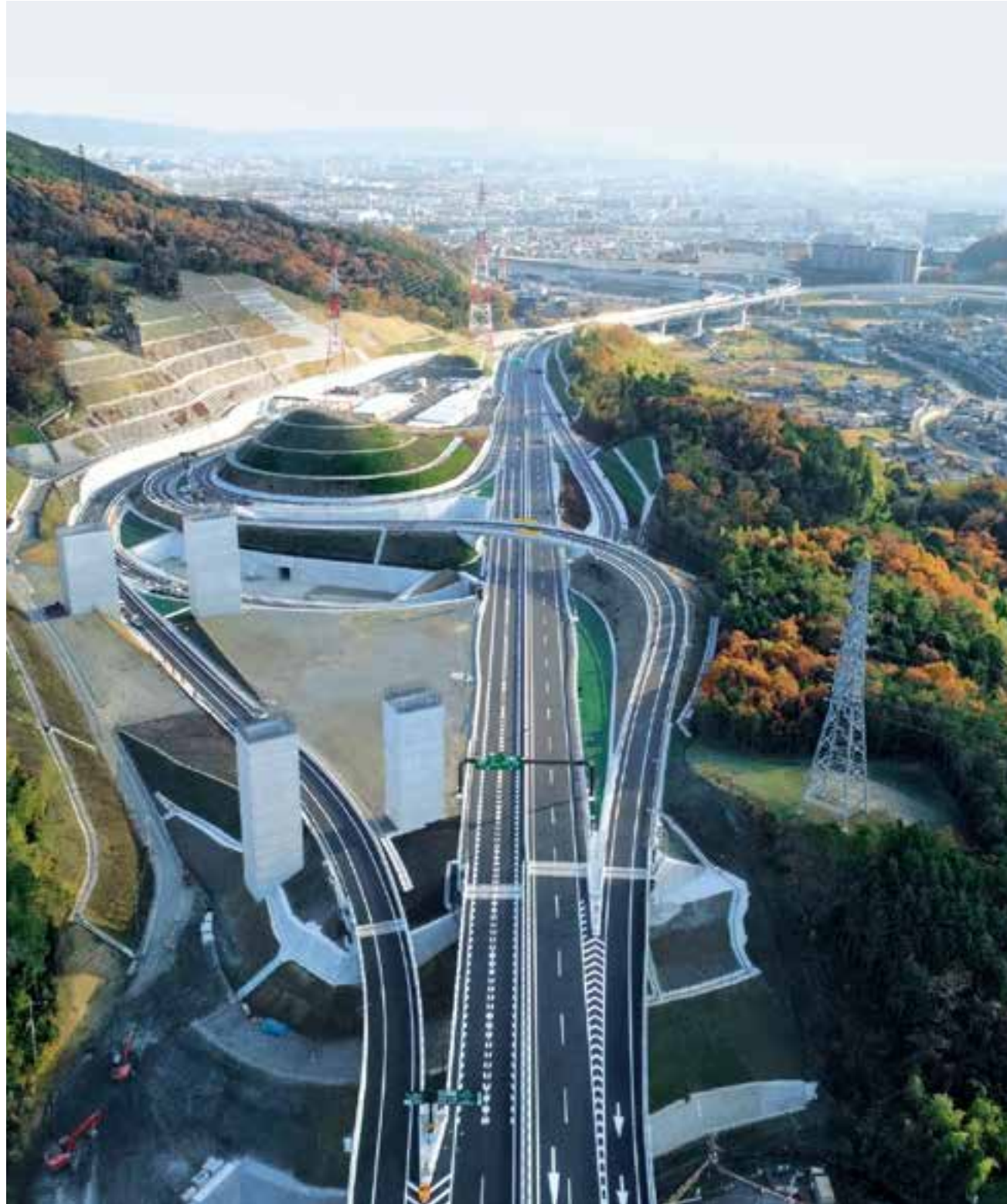
新名神高速道路 高槻インターチェンジ |大阪府|2019|
