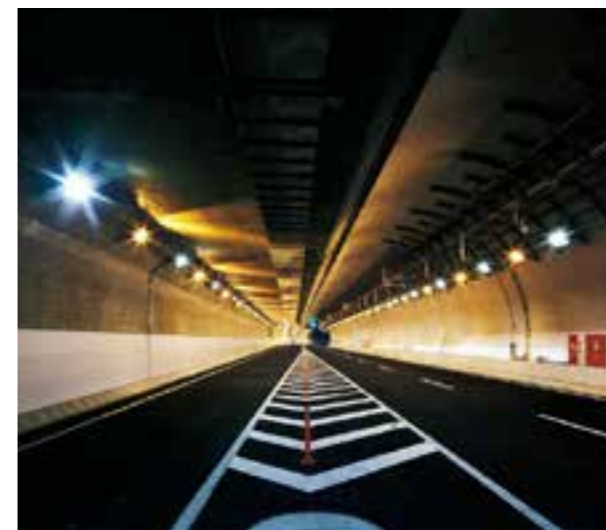
首都高速道路 中央環状品川線 (五反田出入口) | 東京都 | 2015 |
