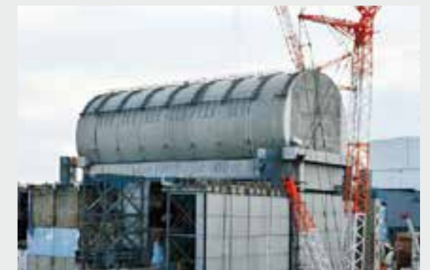
福島第一原子力発電所3号機燃料取り出し用カバー設置工事
