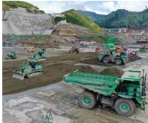
成瀬ダムで堤体打設を行う自動化重機
