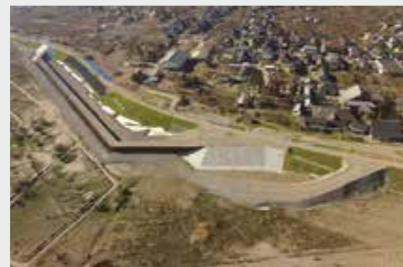
令和元年台風19号で決壊し緊急復旧工事を行った千曲川堤防
