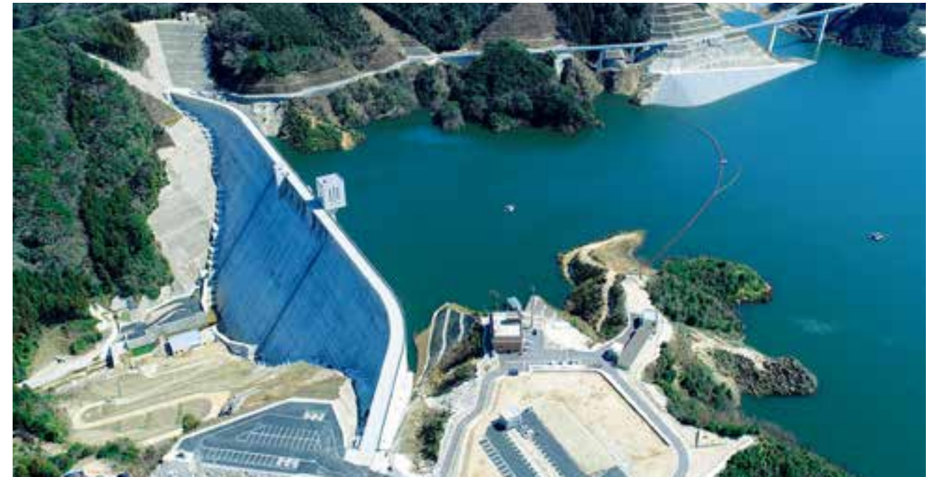
五ヶ山ダム |福岡県|2018|
