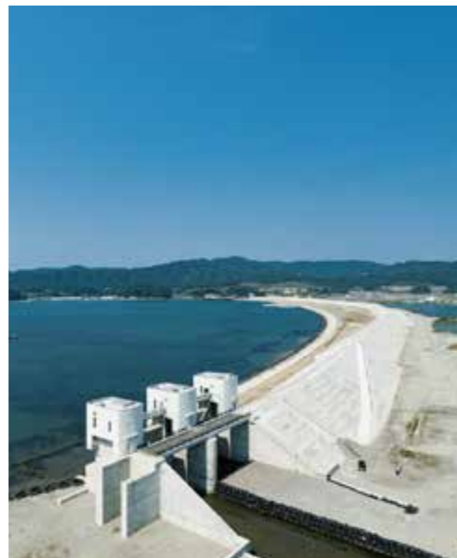
高田地区海岸災害復旧工事 | 岩手県 | 2016 |
