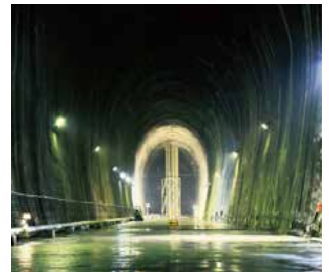
倉敷国家石油ガス備蓄基地 | 岡山県 | 2012 |
