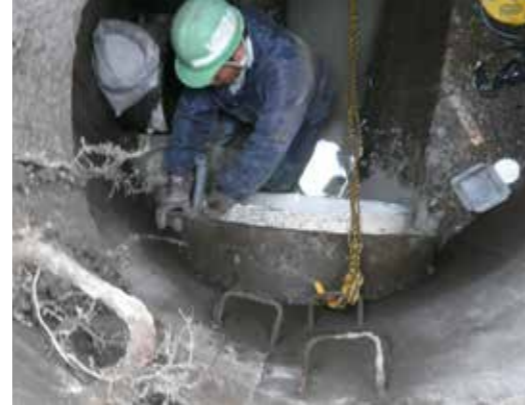
千葉県市原市 施工状況
