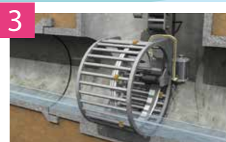
3 ストリップ先端を製管機にセット
