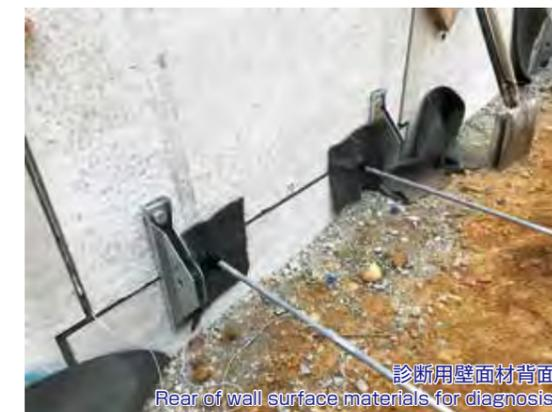
上下の壁面材はダブルコネクタにより連結
