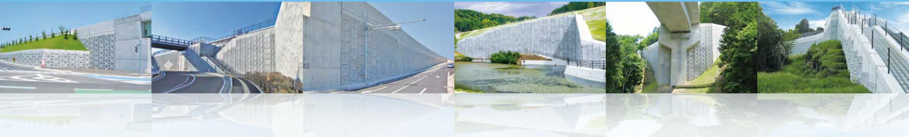
多数アンカー式補強土壁工法は、1970年に旧建設省土木研究所にて考案された「杭張材を用いた盛土安定増大工法」を原案とするわが国独自開発の補強土壁工法です。幅広い盛土材を適用できる特性を活かしての建設発生土の有効利用や高い耐震性、環境負荷の軽減、そして優れた安定性を併せ持っています。これまでの30年以上の実績を踏まえ、2014年8月には「多数アンカー式補強土壁工法設計・施工マニュアル第4版」(一般財団法人土木研究センター)が発刊され、ますます信頼性が向上しました。
