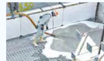
多数アンカー式補強土壁は、アンカーの支圧抵抗力を拠所とすることから、粒度の大きい岩から細粒土などの現場発生土まで様々な盛土で補強土を構築することができます。
