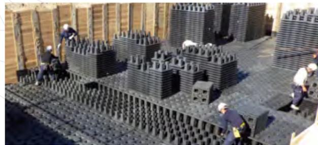
近年、局地的な大雨等が頻発していることから、雨水による幹線道路の交通への支障や床上浸水による被災など、甚大な被害が発生しています。また造成などの開発行為を行う際には、敷地内に調整池を設置することが義務付けられています。当社はプラスチック製雨水貯留浸透槽「ジオプール工法」で土地の有効活用と雨水の貯留・浸透対策に対応しています。
