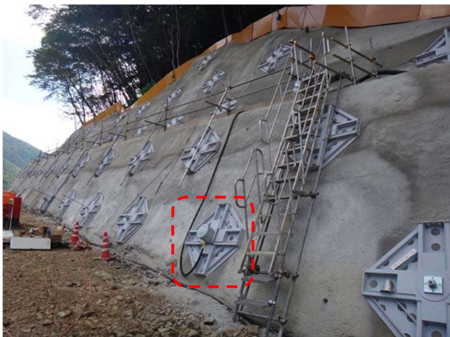
赤谷地区溪流保全工他工事でグラウンドアンカー適用状況 (2017年6月、赤枠内が本技術を適用した箇所)
