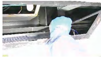
狭隘部への挿入状況
